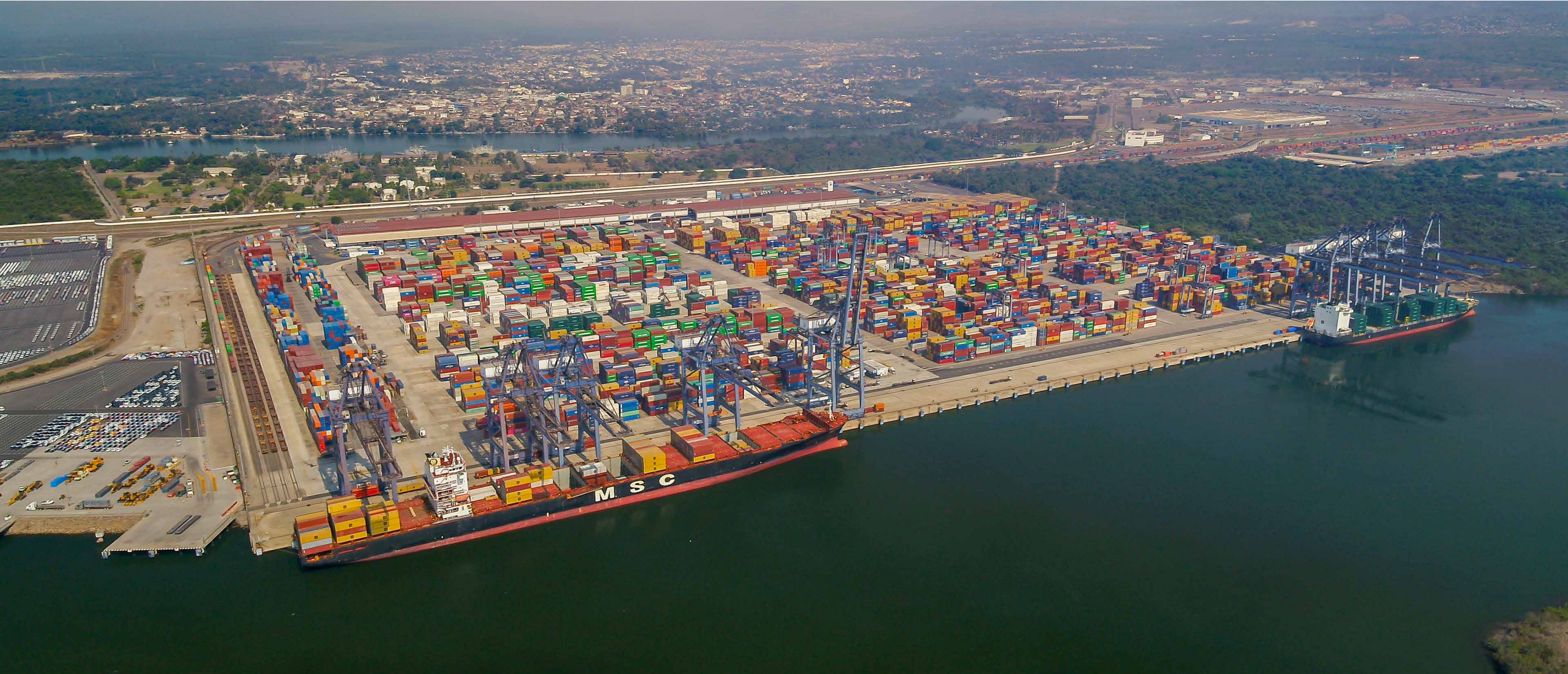
TERMINAL DE CONTENEDORES DEL MUELLE LÁZARARO CÁRDENAS, MICHOACÁN LAZARO CARDENAS CONTAINERS PORT TERMINAL QUAY DECK MICHOACAN, MEXICO
